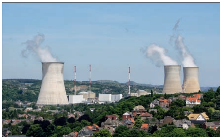
L'impianto di Tihange.
